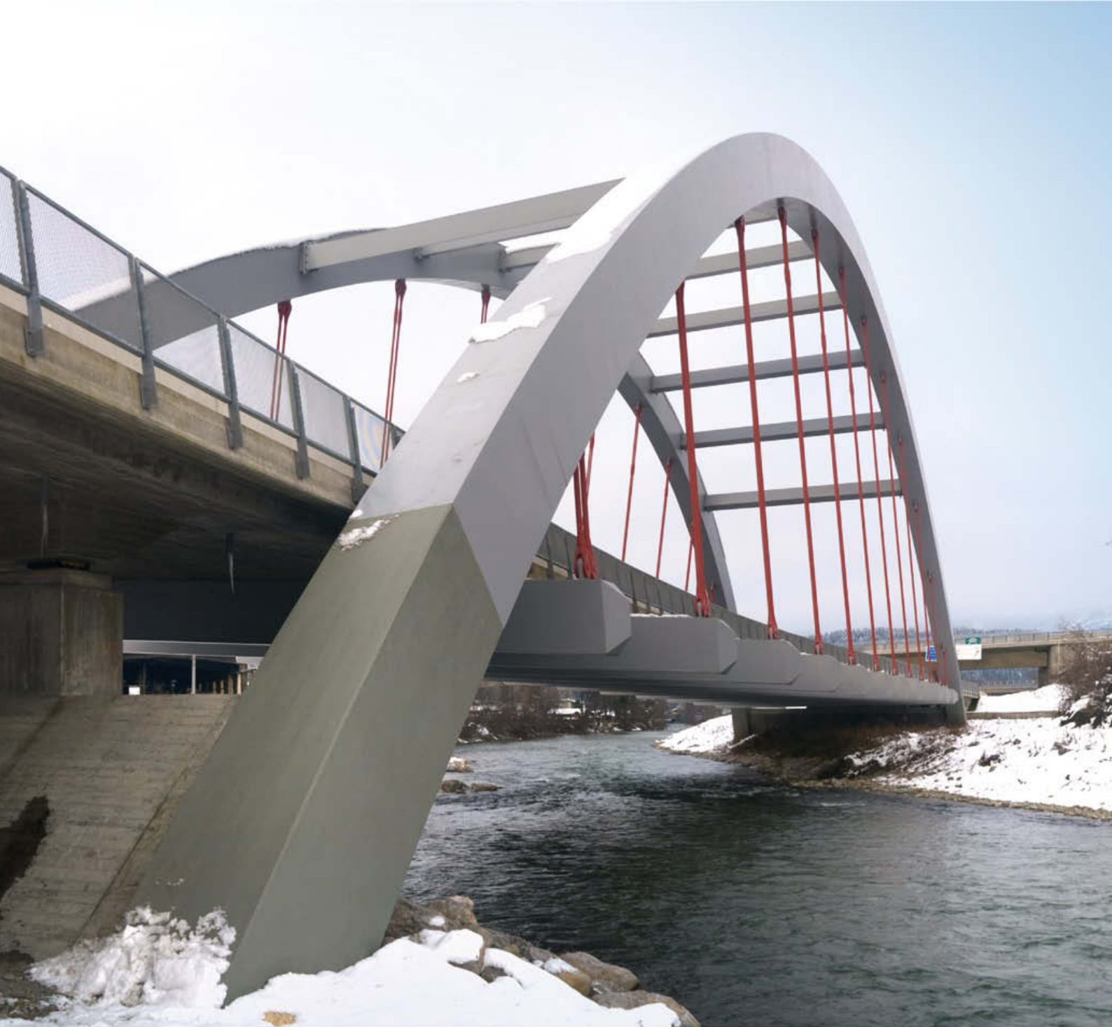
Umfahrung Wörgl-Bruckhäusl Baulos 3, Tirol
