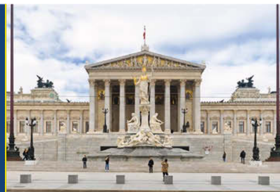
Im Zuge der Rampen- und Brunnensanierung des Parlamentsgebäudes in Wien wurden die Rampen- und Stufenanlage abgetragen und vollständig neu aufgebaut sowie Steinrestauratorenarbeiten durchgeführt.
