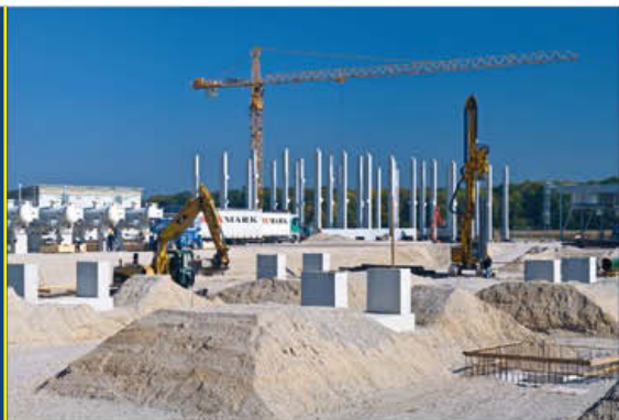
Beim Projekt OMV Verdichterstation in Niederösterreich wurden 10.000 m 2 Asphalt verlegt und 600 m 3 Betonfundamente hergestellt. Das voraussichtliche Bauende ist Oktober 2008.
