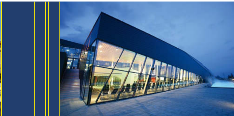
Die Aqualux Therme Fohnsdorf in der Steiermark mit einer Bruttogeschosßfläche von 9.000 m 2 und einer Wasserfläche von 900 m 2 wurde in nur 14 Monaten erbaut.
