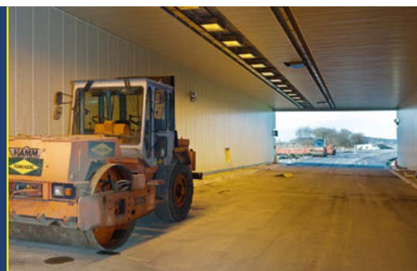
Das Projekt Querspange Gnas , Steiermark, umfasst die Herstellung von Lärmschutzwänden, 3,2 km Straße inklusive Kreisverkehr sowie zehn Brücken. Im Sommer 2009 soll der Auftrag im Wert von 8 Mio. EUR fertiggestellt werden.
