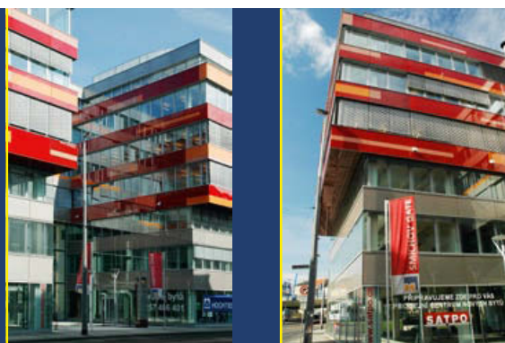
Das Bürogebäude Smichov Gate , Prag, gliedert sich in acht Geschoße mit einer Bruttogeschoßfläche von ca. 20.000 m 2 und wurde im Herbst 2006 fertiggestellt.
