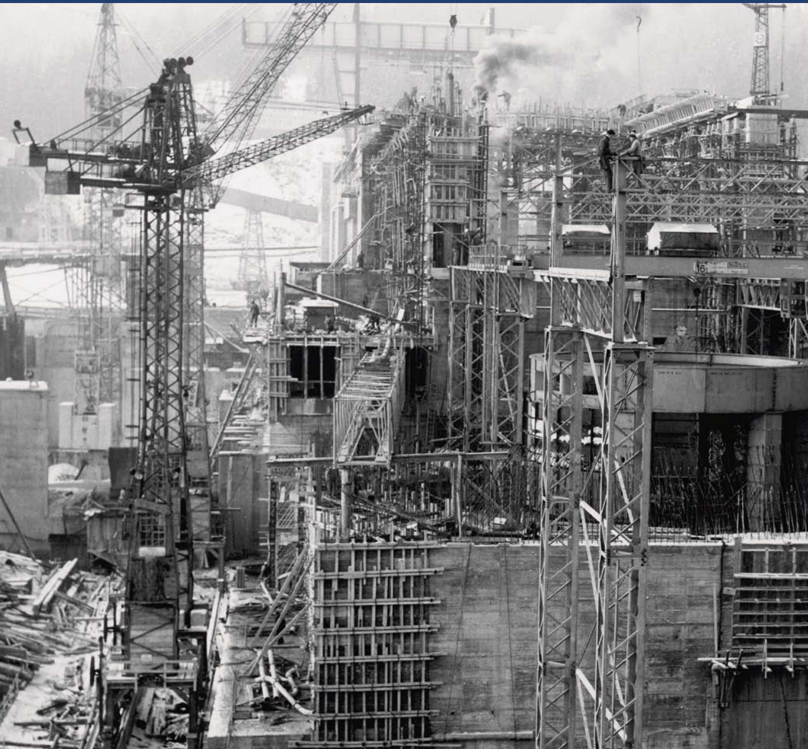
Donaukraftwerk Aschach, Oberösterreich
