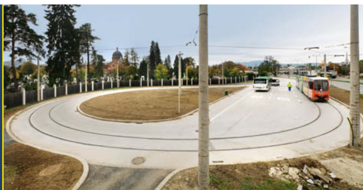
Die Straßenbahnlinie 6 in Graz , Steiermark, wurde von April 2006 bis Oktober 2007 verlängert. Rund 19.500 m 3 Boden wurden abgetragen, 11.000 m Kabel verlegt und 8.700 m 2 Gehsteige errichtet.
