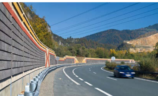
Eine rund 3,8 km lange Lärmschutzwand bei Deutschfeistritz wird seit Sommer 2007 auf der S 35 Brucker Schnellstraße errichtet, inklusive Pfahlfundamenten, Versetzen von Stahlstehern, Betonfertigteilen sowie Lärmschutzwandelementen.
