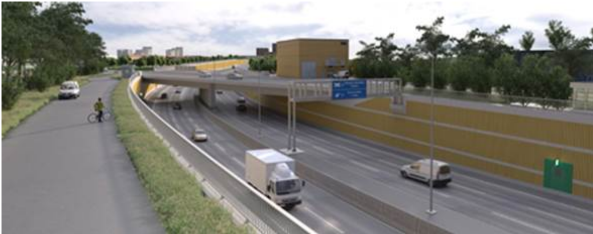
Foto: Blick auf das fertiggestellte Trogbauwerk und auf die SÜ Kieffholzstrasse / © ARGE SRB
