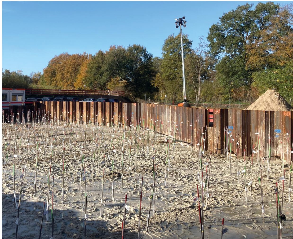
Baufeld nach Einbau der Injektionslanzen
