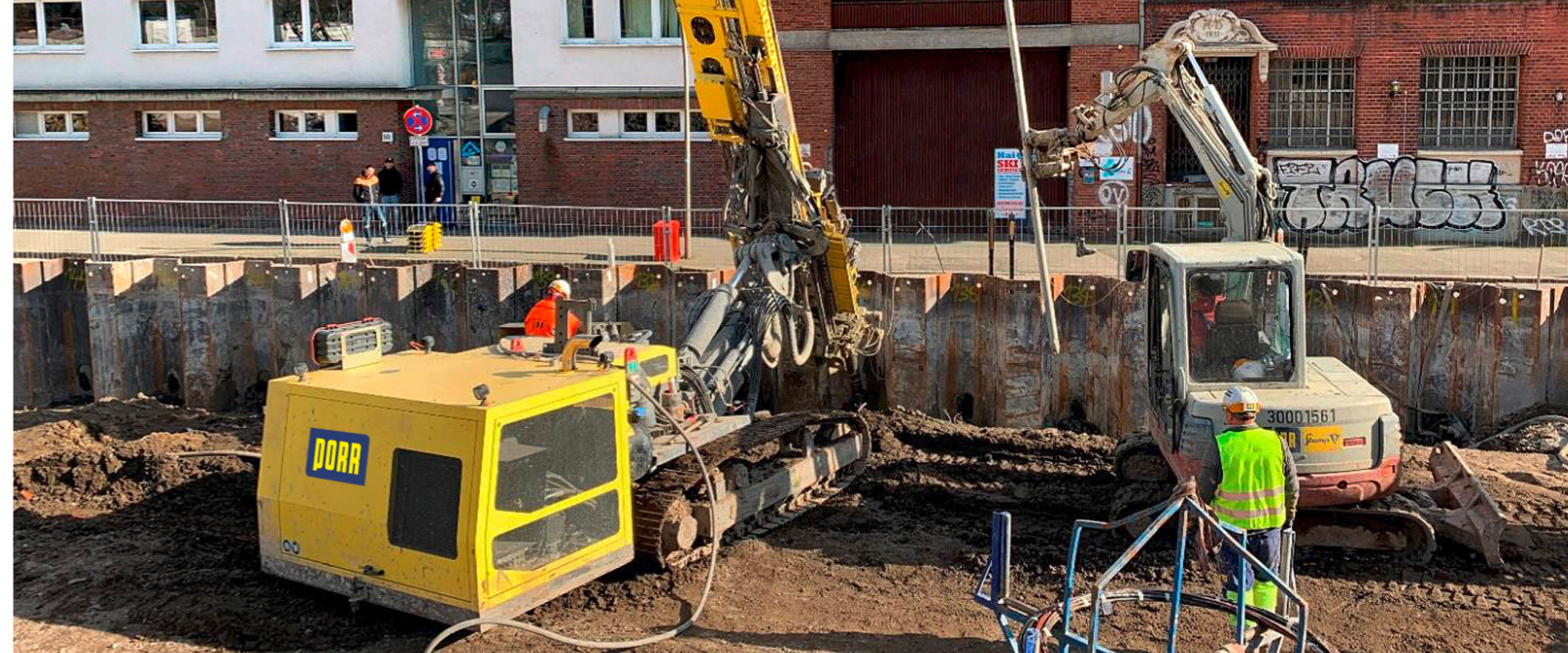
Verankerung einer Spundwand in Hamburg
