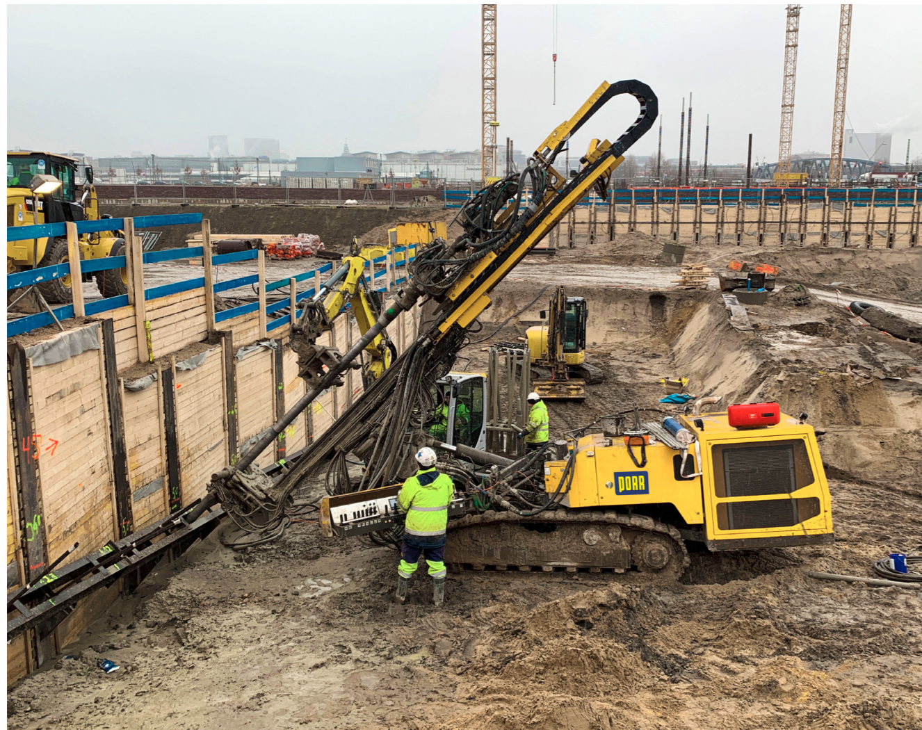
Kurzzeitanker für eine Bohrfahlfwand
