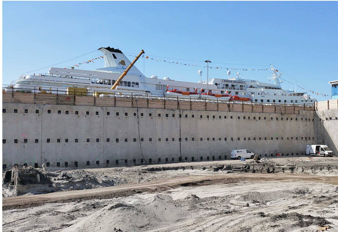
Ankerherstellung unterhalb des Grundwasserspiegels. WESTFIELD HAMBURG-ÜBERSEEQUARTIER.
