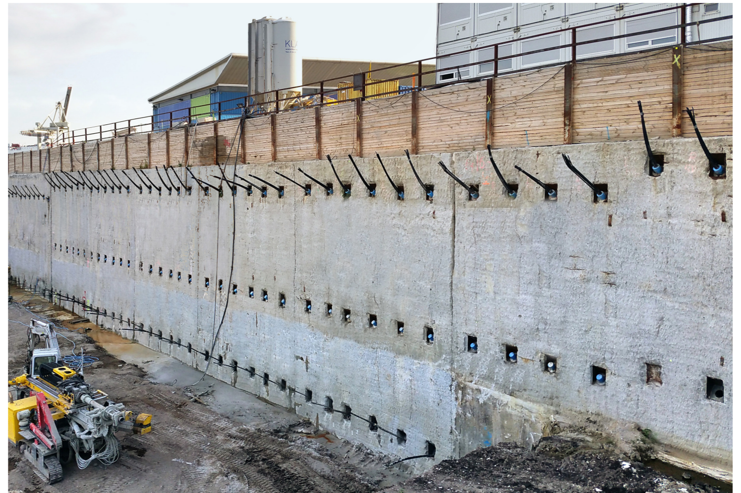
Rückbaubare Litzenanker in der obersten Ankerlage. WESTFIELD HAMBURG-ÜBERSEEQUARTIER.
