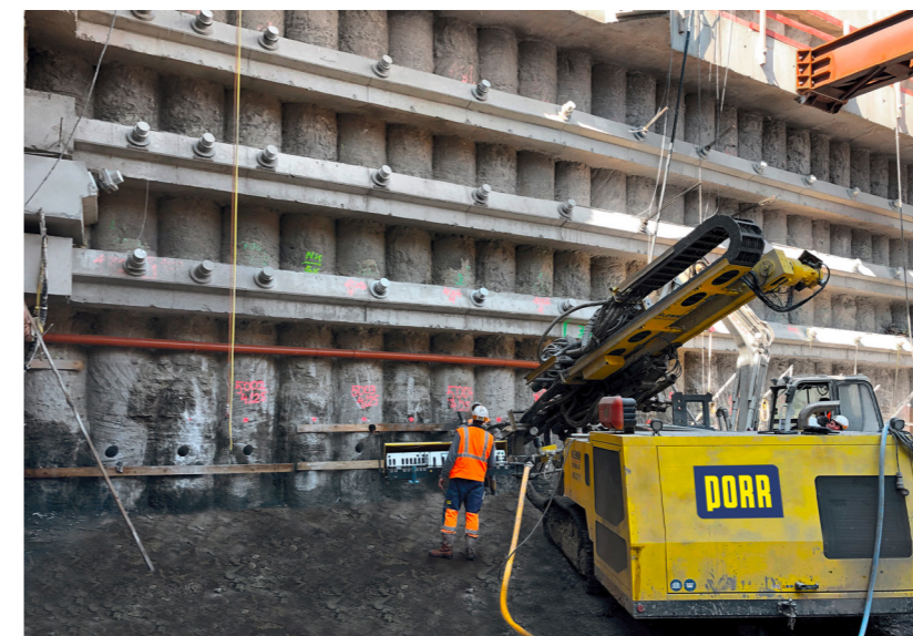
Mehrlagige Rückverankerung einer Bohrpfahlwand
