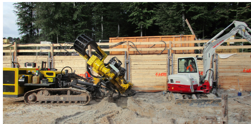
Einsatz von Staffelankern auf der Baustelle FAIR in Darmstadt
