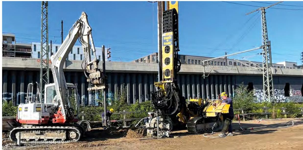
Bohrung mit Außenspülung für Mikropfähle
