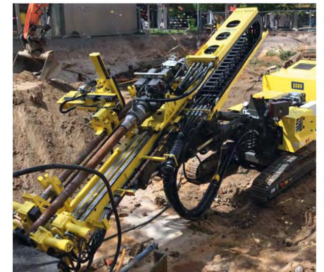
Bohrung mit Außenspülung für eine geplante Rückverankerung.
