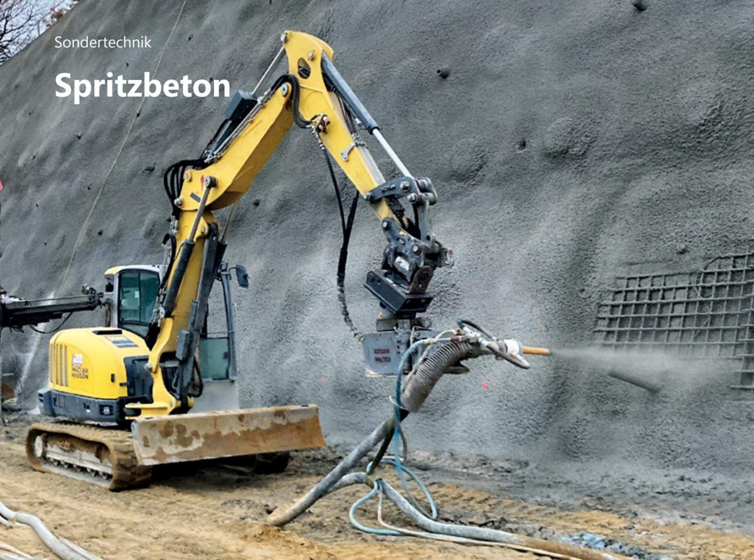
Böschungssicherung mit Spritzbeton
