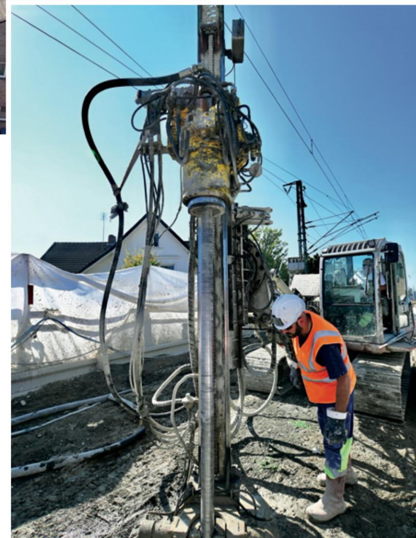
Herstellung der DSV-Säulen sowohl in Sperrpausen als auch unter Eisenbahnbetrieb
