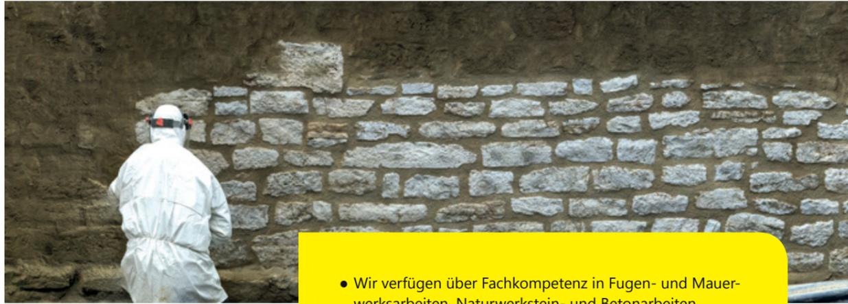
Verfugen und reinigen von Mauerwerk aus Naturwerkstein
