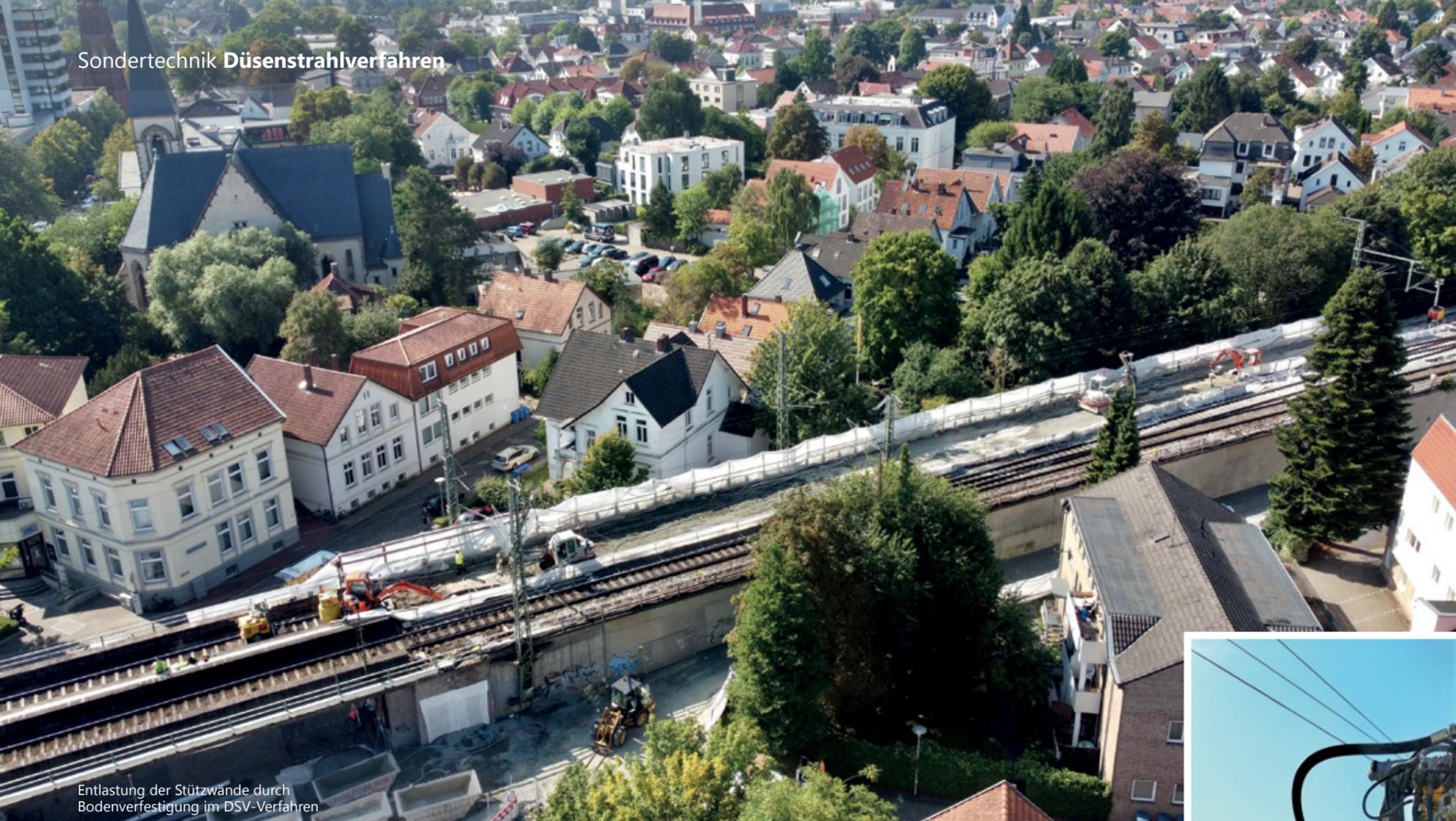
Entlastung der Stützwände durch Bodenverfestigung im DSV-Verfahren
