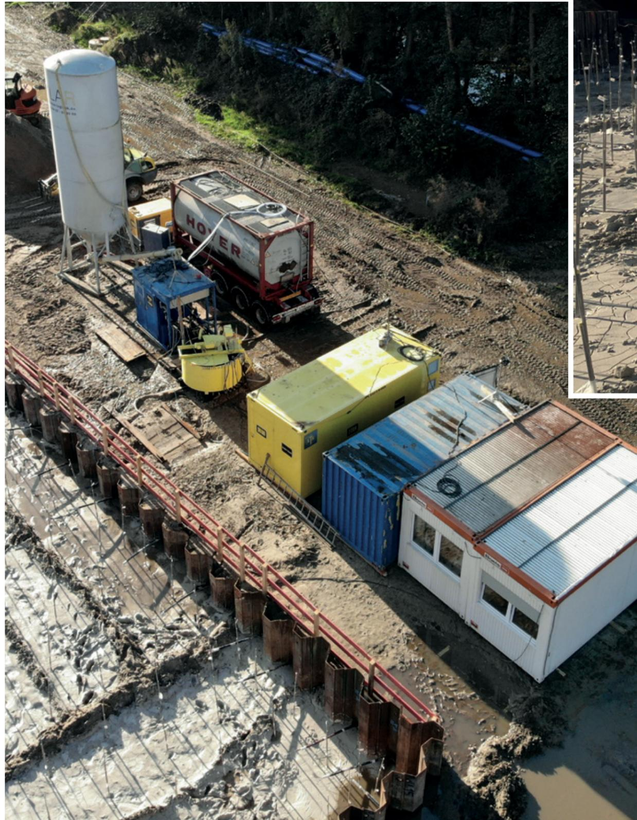
Baustelleneinrichtung für die Herstellung einer Weichgel-Injektionssohle
