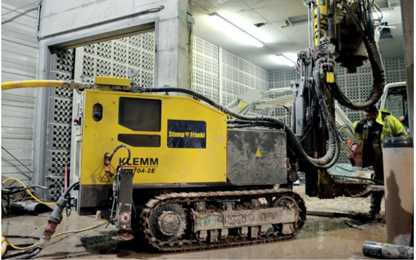
Die Bohrarbeiten unter eingeschränkter Höhe erfolgten mit Elektroantrieb ohne Abgasemissionen.
