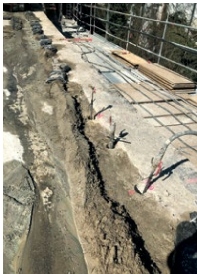
Bohrungen mit Packern besetzt zur Verpressung
