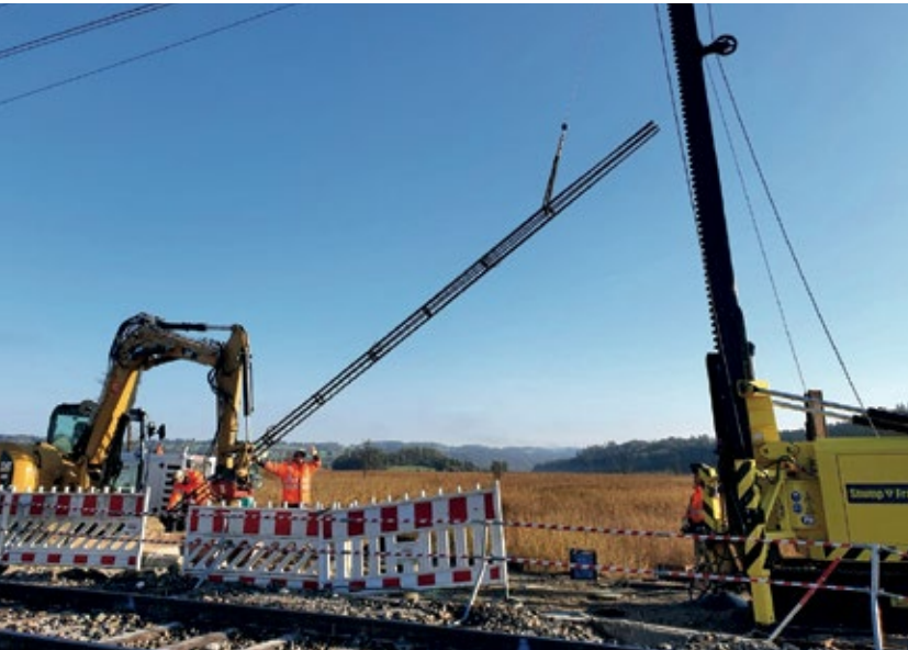
Die Rammarbeiten wurden direkt neben der Bahnstrecke mit ausreichend Abstand zur Oberleitung ausgeführt.
