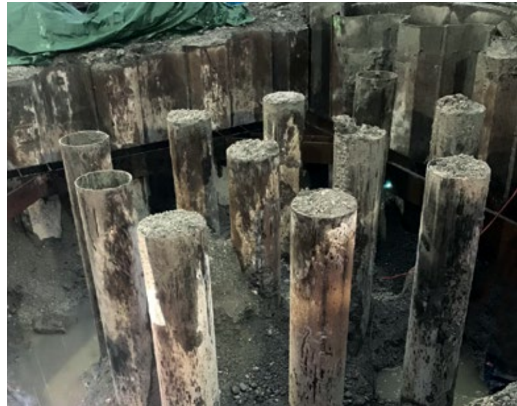
Freigelegte Stahlrohrpfähle im Spundwandkasten. Foto von Strabag Rail
