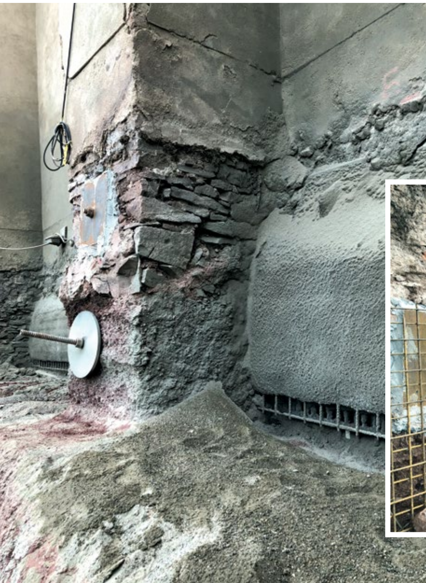
Temporäre Sicherung mittels bewehrter Spritzbetonschale.
