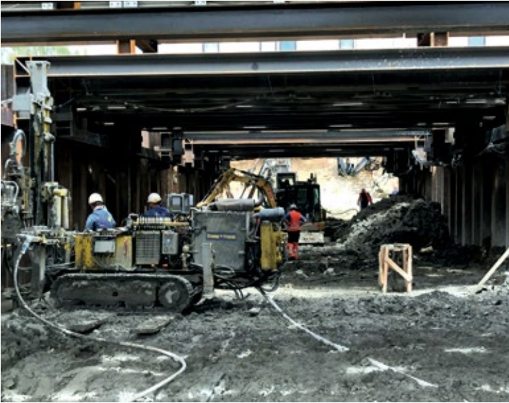
Herstellung einer DSV-Dichtsohle im Fußgängertunnel.
