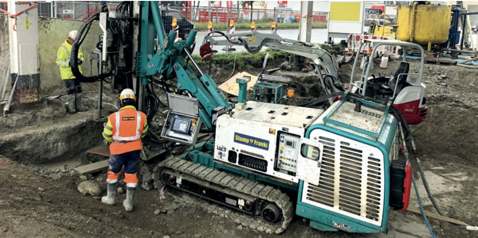
DSV-Arbeiten auf dem Tankstellengelände
