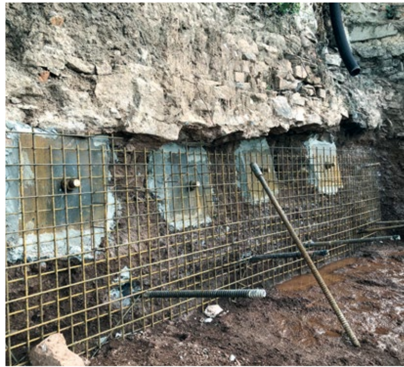
Sicherungsanker mit Ankerplatten 50 x 50 cm
