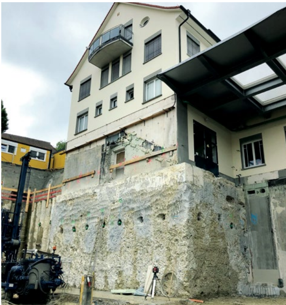
Eine rückverankerte DSV-Unterfangung sichert das Bestandsgebäude.
