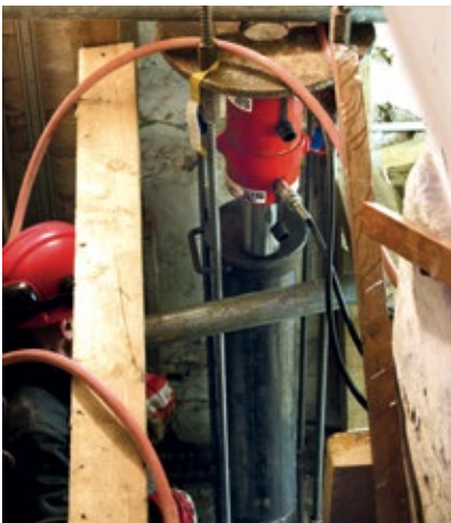
Einpressen eines Pfahlelementes
