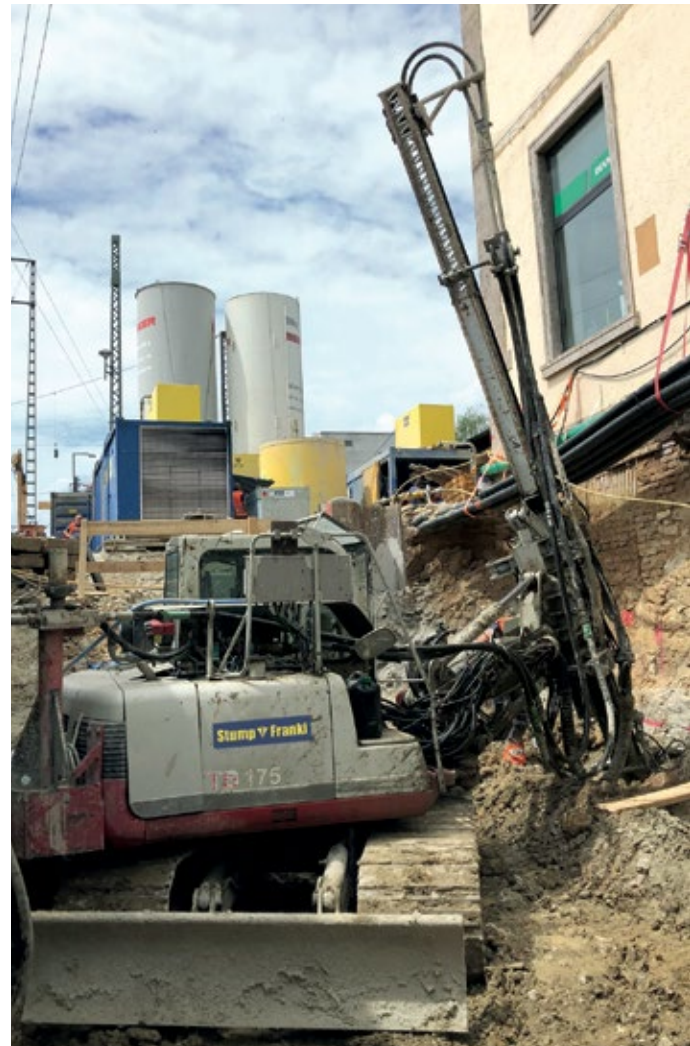
Gebäudesicherung mit DSV-Säulen.
