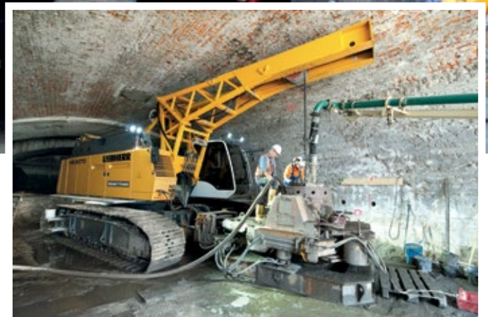
Nach oben zum Gewölbemauerwerk waren nur wenige Zentimeter Luft.
