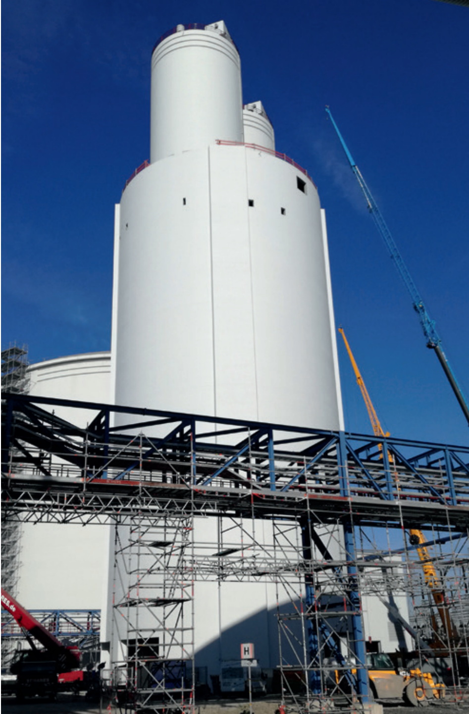
Kraftwerk Datteln, Flugascheverladesilo
