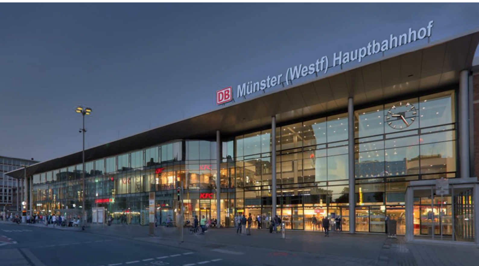
Ansicht des Empfangsgebäudes
