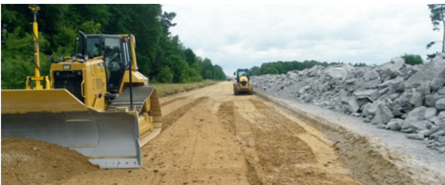
BV A9 Nähe AS Klein Marzehns: Erdbau und Herstellen des neuen Planums
