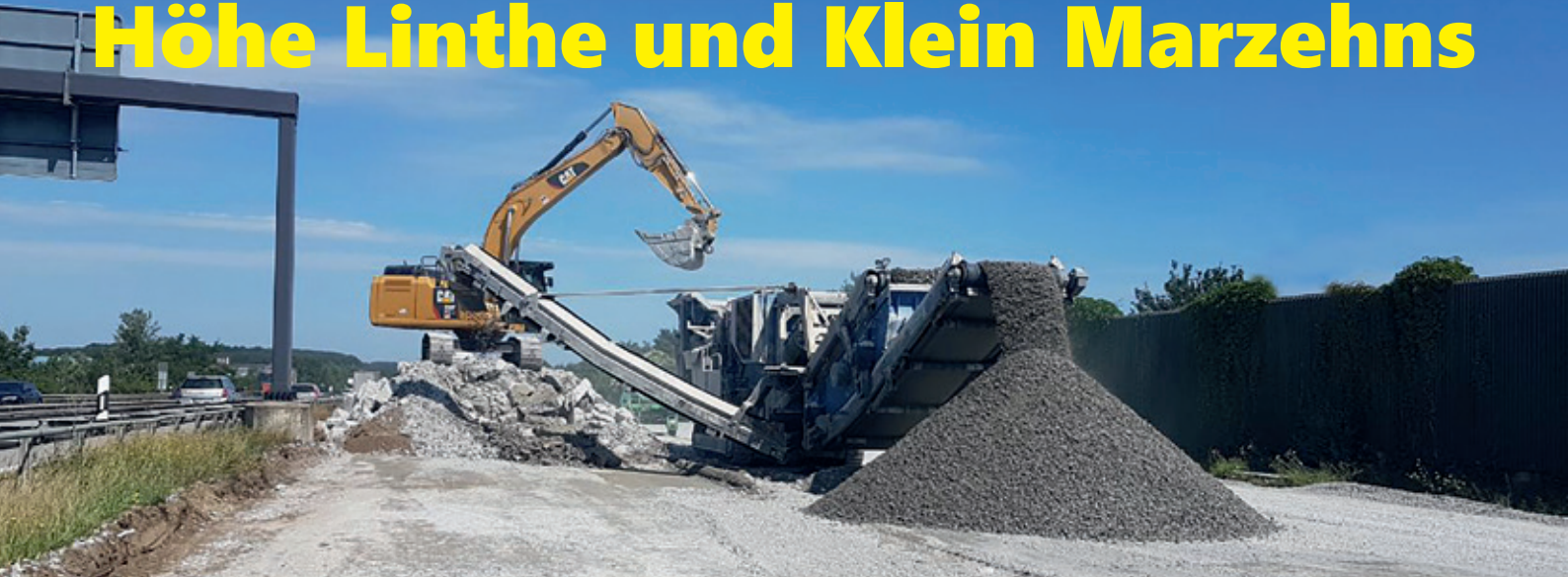
Bauvorhaben A9 Nähe Anschluss Linthe: Brechen und Aufbereitung des alten Fahrbahndeckenbetons
