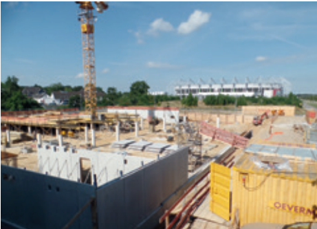
Blick über die Baustelle in Richtung Stadion des Borussia VfL 1900 e.V.
