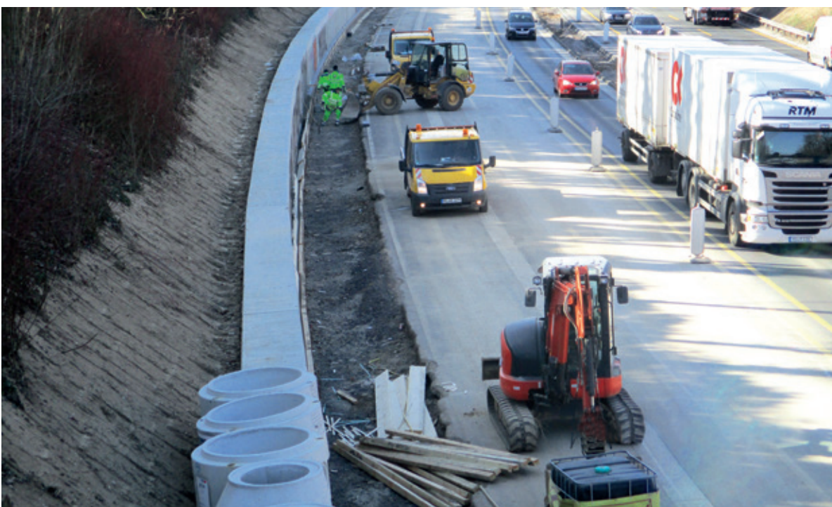
Übersicht über die Baustelle in Fahrtrichtung Sankt Augustin in Bauphase 3
