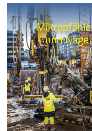
Verdrängungsbohrpfähle
