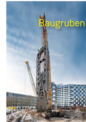
Düsenstrahlverfahren
